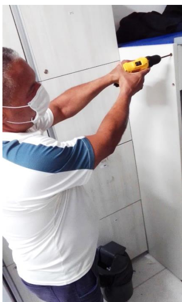
Instalação dos beliches
