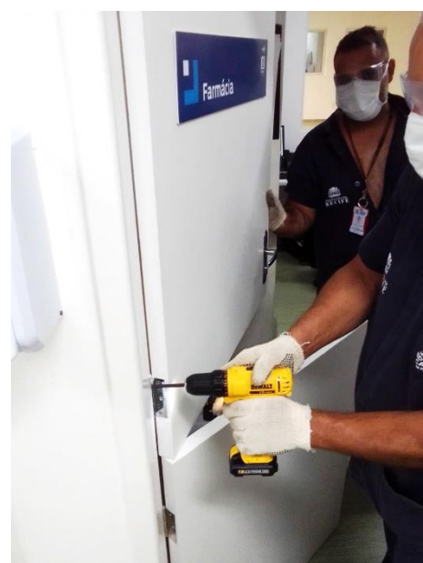
Modificação na estrutura da porta da farmácia UTI
